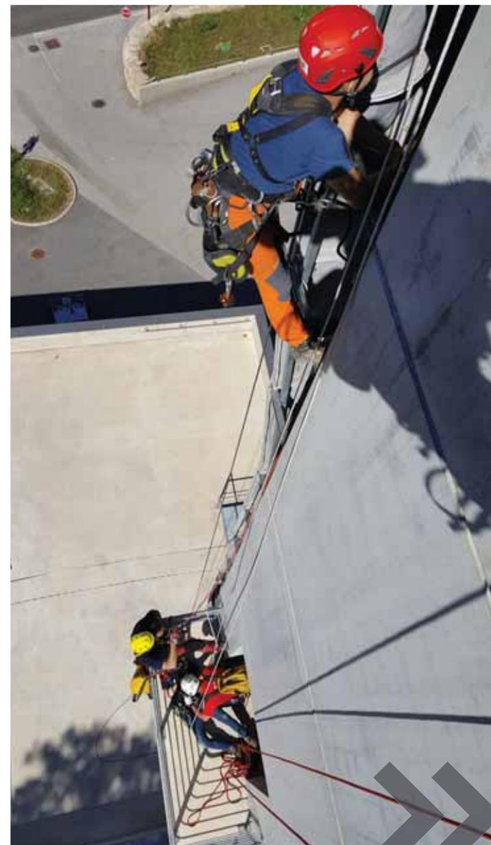
**Tout chantier réalisé par des cordistes** nécessite une analyse préalable des risques pour entre autres préciser les mesures à prendre en cas d'évacuation et de secours. Les cordes d'accès au poste de travail sont de ce fait équipées lisiblement pour faciliter leurs utilisations par un coéquipier, voire les secours spécialisés.
